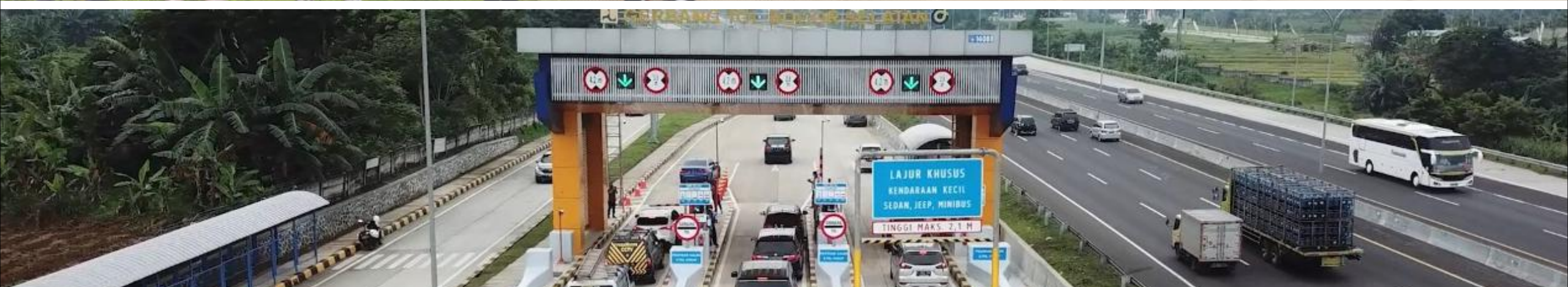
Pintu Tol Bogor Selatan Operasional (7 April 2021)
